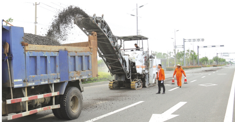
为进一步改善园区道路环境，助力创建全国文明城市。5月份以来，华茂盛达市政公司对辖区东方大道、黄海大道等主干道近10000平方米破损路面进行维修，计划在5月20日完工，预计创收约200万元。图为黄海大道沥青路面起创作业现场。(房金鹤 梁作东)
