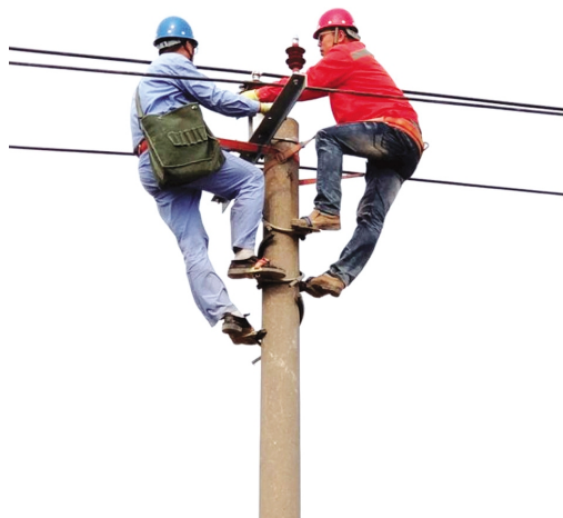
5月2日,张圩新农村小区配电安装工程施工现场,荣获集团“技能大师”称号的台南供电所职工王建采用实践教学的方法,亲自为新员工祁明智做登杆、金具安装、导线捆绑等示范操作,促其尽快掌握技术要领。自从供电公司通过“师徒结对”等活动载体,培育出一批又一批的业务骨干和中坚力量,助推企业高质量发展。(台南供电所)
